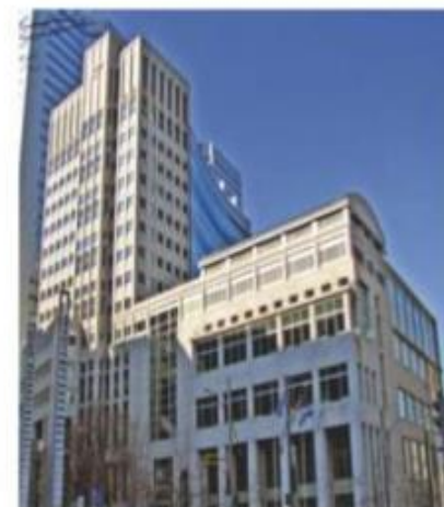
Здание ВАДА в городе Монреаль, расположенное по адресу: Stock Exchange Tower, 800 Place Victoria Suite 1700, P.O. Box 120, Montreal, Quebec, H4Z 8B7, Canada
